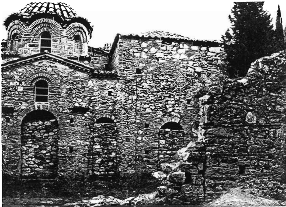
Εικ.12. Αγία Σοφία. Διαρρήξεις σε αναστηλωμένους τοίχους του ναού, που προέρχονται από φαινόμενα ερπυσμού που λαμβάνουν χώρα, λόγω της παρουσίας του αποσπασμένου μανδύα των σχιστολίθων.
